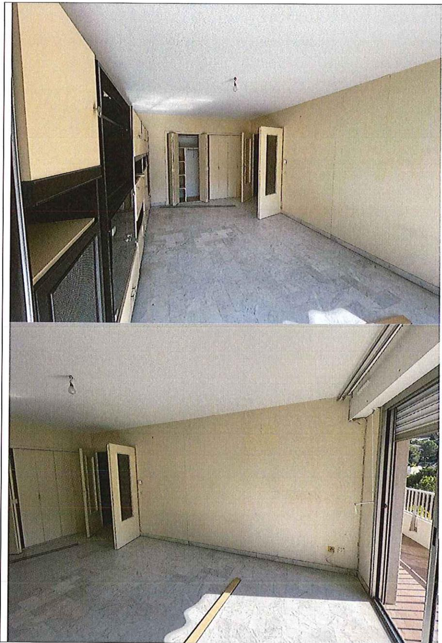
Il s'agit d'une grande pièce rectangulaire exposée Sud au moyen d'une grande baie vitrée à deux vantaux coulissants, menuiseries en aluminium, un carreau de vitre simple vitrage. L'obscurité est assurée par des volets roulants à lamelles à commande manuelle.
